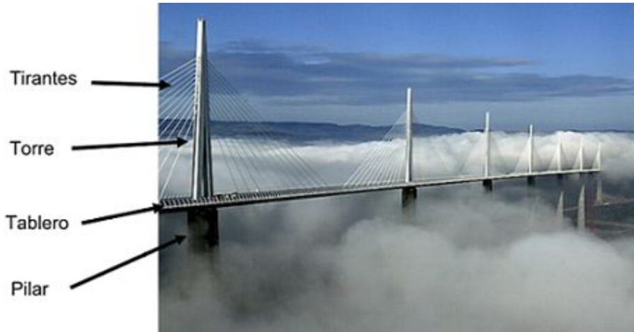
Figura 2. Partes fundamentales de un puente atirantado
